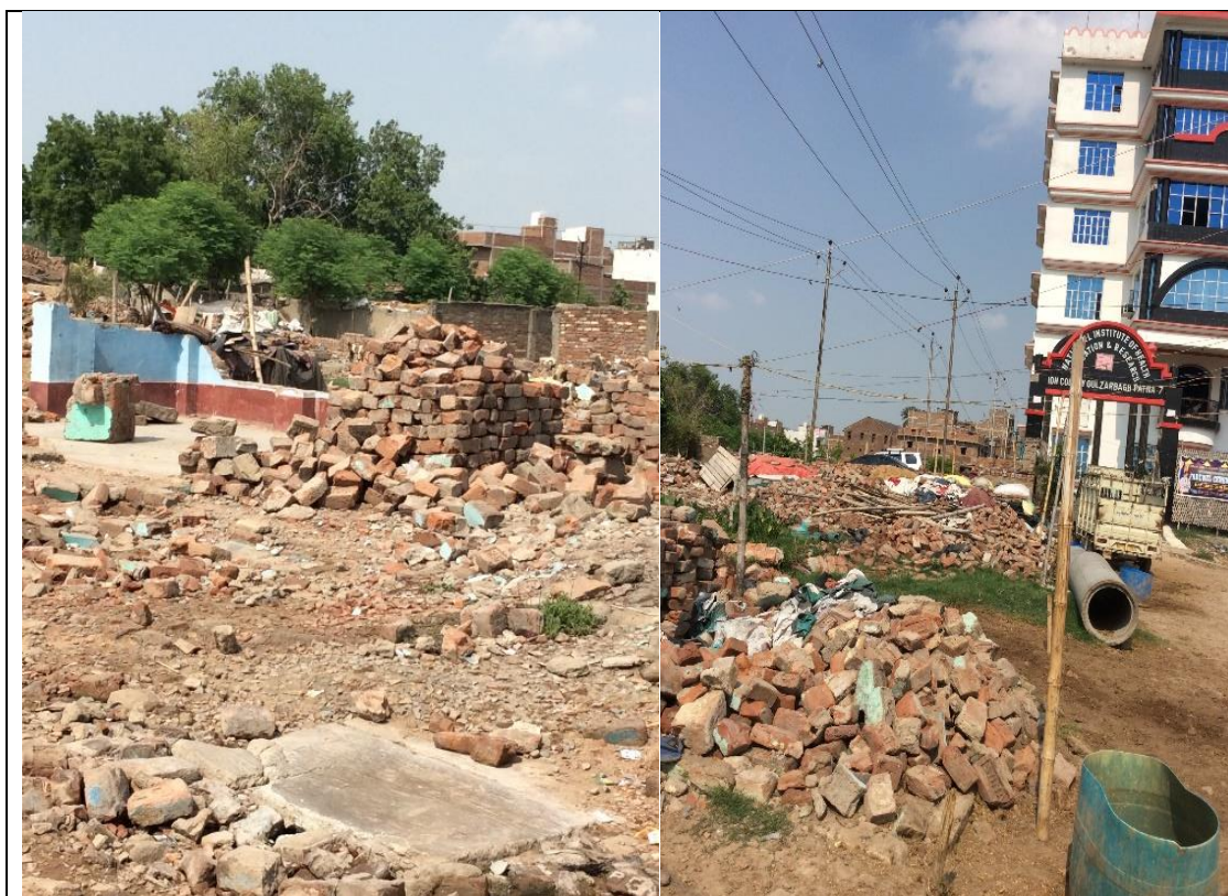
Image No 6.4: Demolished Meena Bazar Kuda Par Basti
